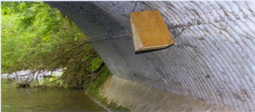
Dreieck-Kasten in einer sog. Thyssen-Röhre. Zur Montage können die Schrauben gelöst und wieder angezogen werden.
