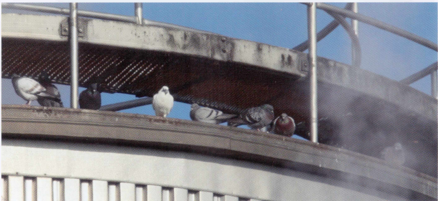
Stadtauben in der Dampfwolke eines Hochbehälters
